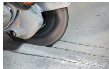
Creazione di tracce su cemento armato.
